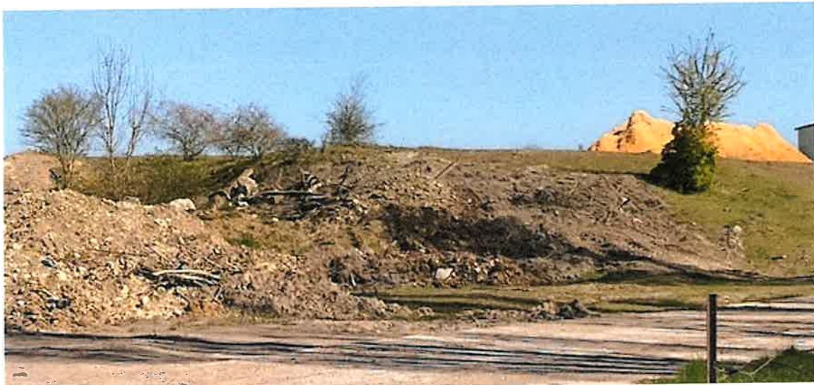
Remblais de talus en cours
