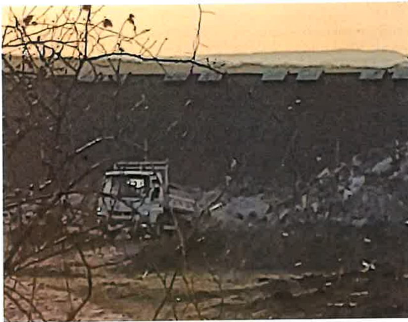
Va et vient de camions d'entreprises différentes sans surveillance
